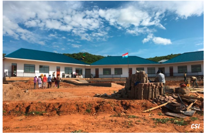
Der Bau und die Renovierung von Schulen, Internaten, Lehrerunterkünften, so wie hier in Tansania, ist einer der Schwerpunkte von CSI
